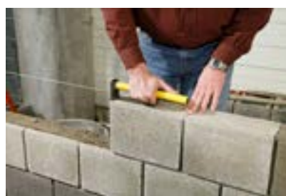
5. Manipulation et réglage du bloc à l'aide de la poignée-massette
