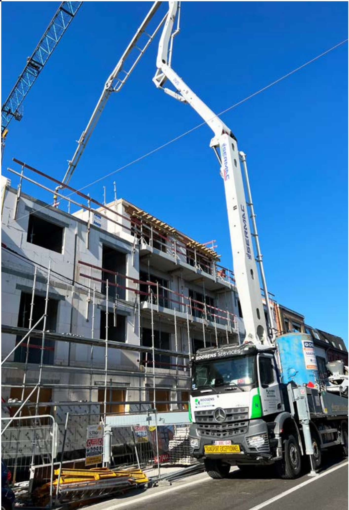
BÉTON PRÊT À L'EMPLOI
