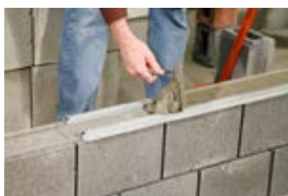
2. Arasement de l'excédant de mortier
