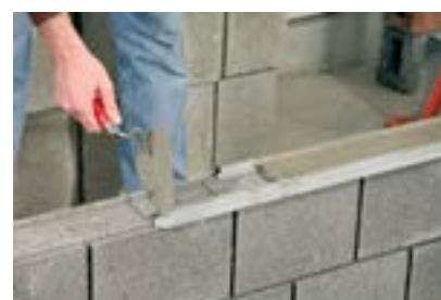
3. Déplacement des réglettes de dosage
